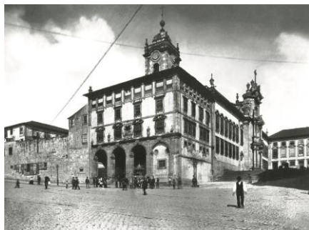
Fig. 2 Convento de São Bento de Avé Maria, Porto. Fotografia Alvão
