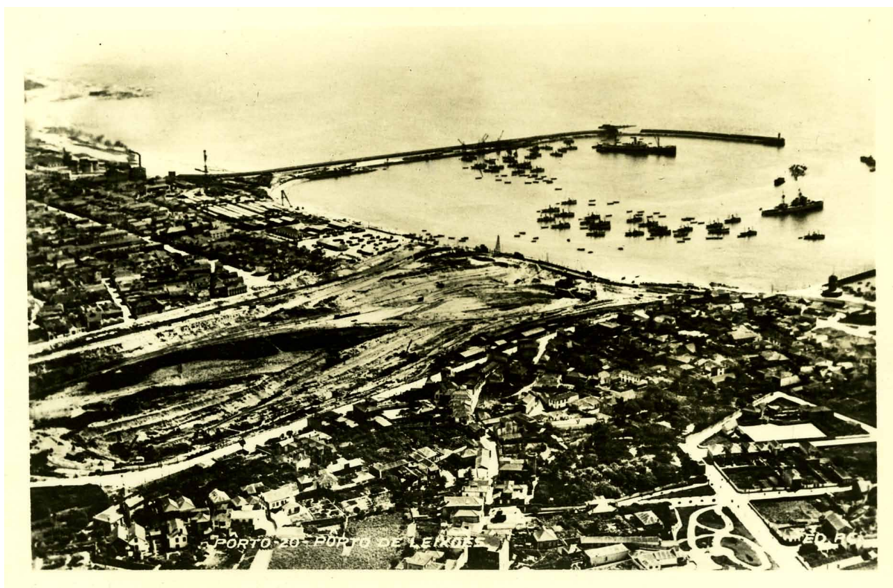
Leixões—L'agrandissement du bassin.
