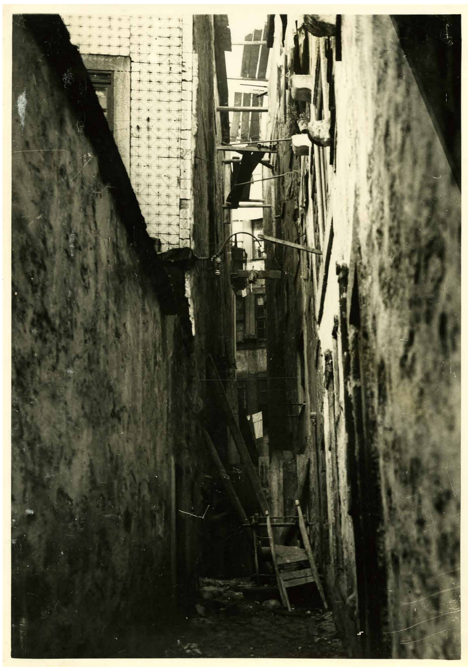
Ruelle do Anjo da Guarda Enfin des travaux! Oui, mais pour conserver l'étroit corridor qui porte le nom de rue de: l'Ange Gardien...
